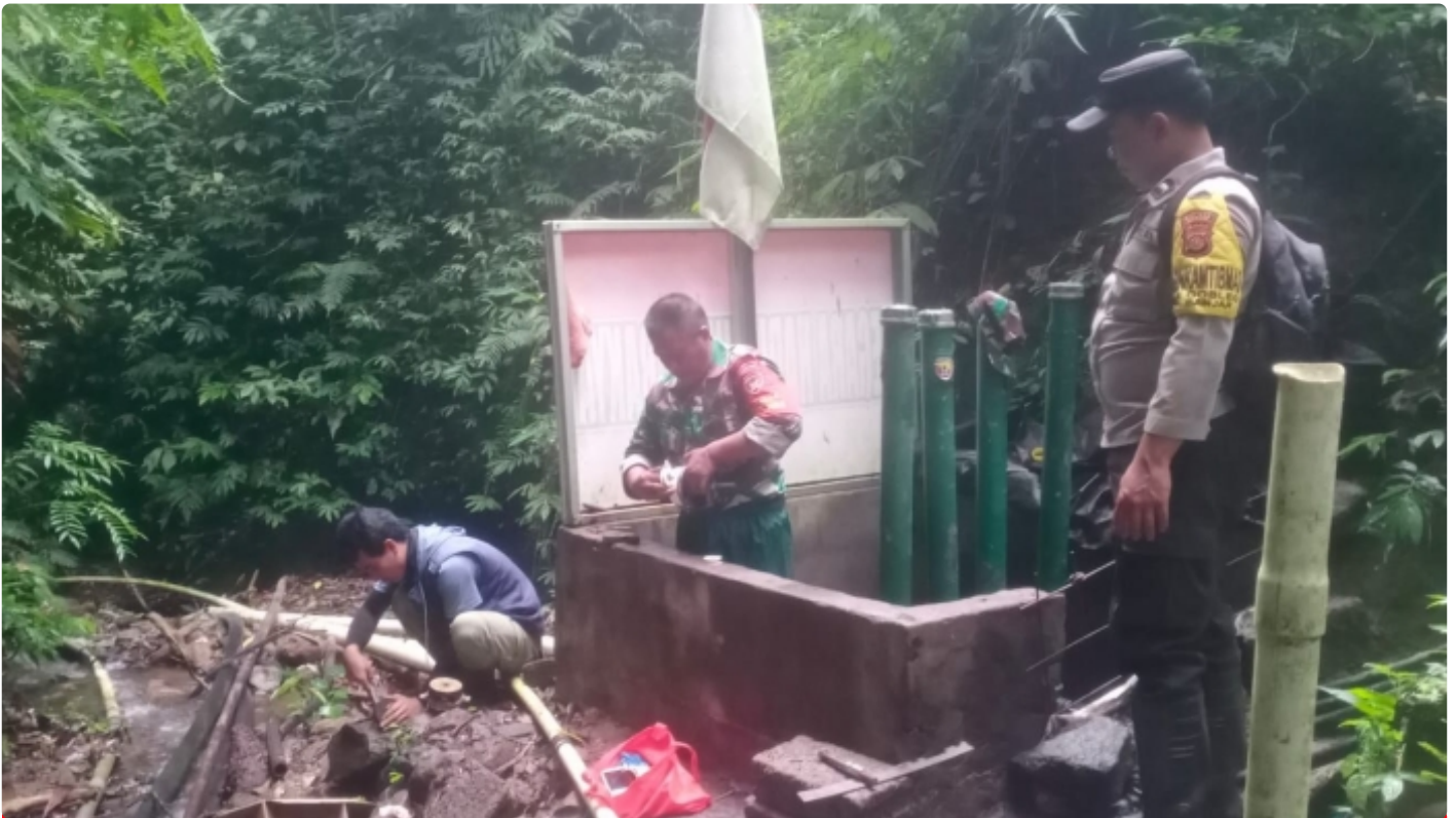
Bantu atasi kesulitan air, Babinsa rutin rawat pompa hydrant di Gobleg
